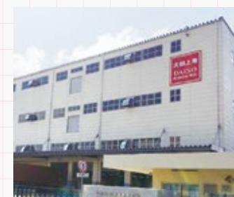
上海倉庫 10,000坪 (33,058m 2 )
