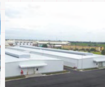
ベトナム倉庫兼工場 6,000坪 (19,835㎡)
