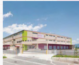
九州RDC 13,500坪 (44,628m 2 )
