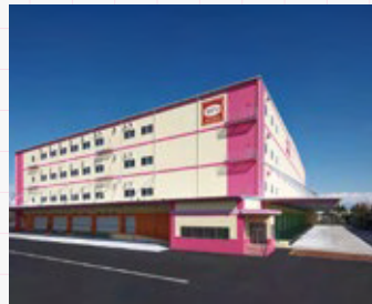
埼玉RDC 18,000坪 (59,504m 2 )
