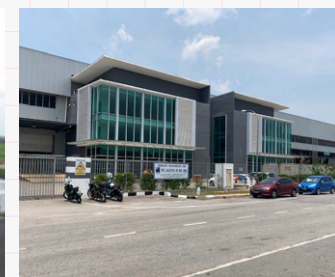
マレーシア倉庫 7,365坪 (24,347㎡)
