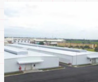
ベトナム倉庫兼工場 6,000坪 (19,835㎡)
