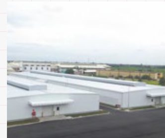
ベトナム倉庫兼工場 6,000坪 (19,835㎡)
