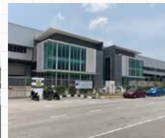
マレーシア倉庫 7,365坪 (24,347㎡)
