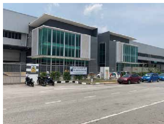
マレーシア倉庫 7,365坪 (24,347㎡)
