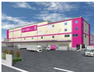
神奈川 RDC 16,200坪 (53,460㎡)
