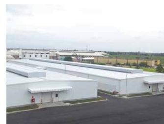
ベトナム倉庫兼工場 6,000坪 (19,835㎡)
