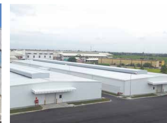
ベトナム倉庫兼工場6,000坪 (19,835㎡)
